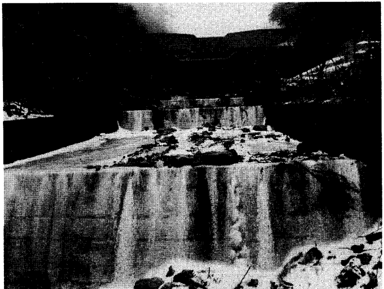
男体山の大薙の堰堤は900mの高さまで幾重にも積み上げられている
