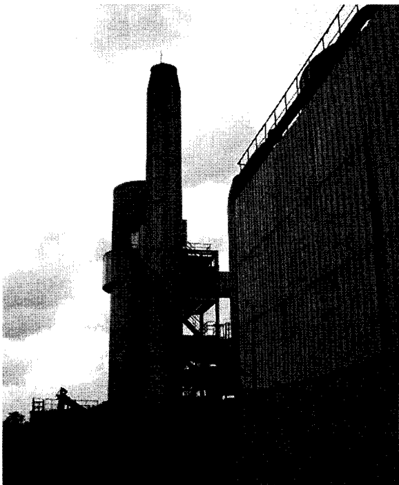
能代バイオマス発電所
